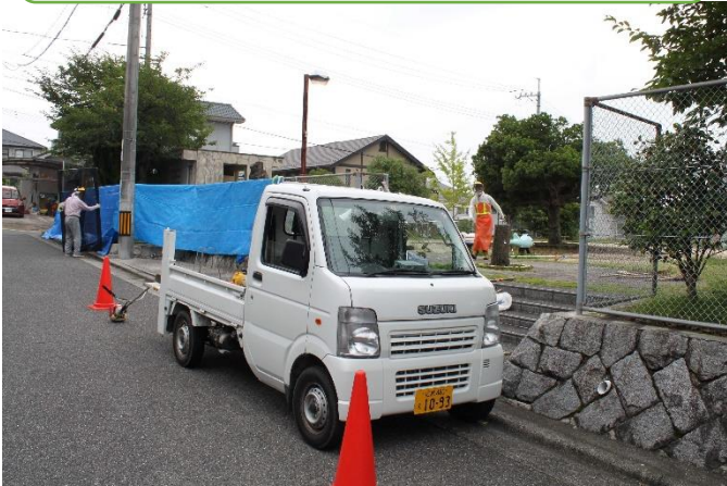
草刈り機による、小石等飛散防止の段取り
